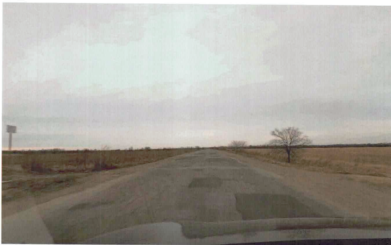
Фото № 12. Выполнение работ по восстановительному ремонту участков региональной сети автомобильных дорог, повреждённых при осуществлении перевозок грузов Концессионером (автодорога с. Мирное –с. Чистополье).
