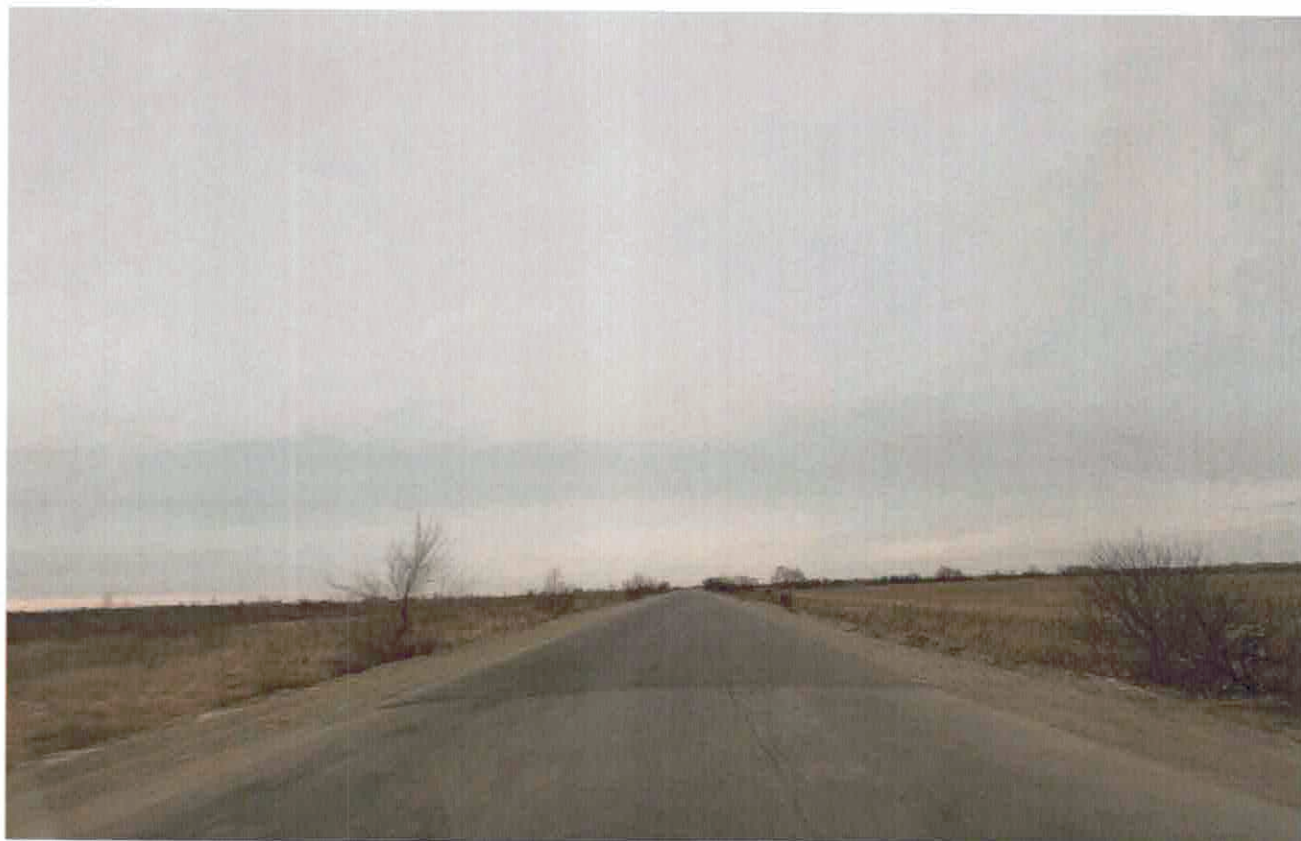
Фото № 13. Выполнение работ по восстановительному ремонту участков региональной сети автомобильных дорог, повреждённых при осуществлении перевозок грузов Концессионером (автодорога с. Мирное – с. Чистополье)
