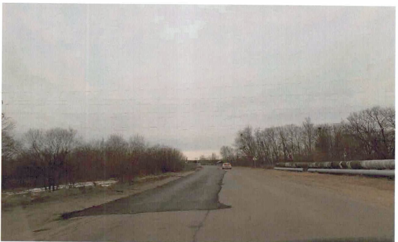
Фото № 15. Выполнение работ по восстановительному ремонту участков региональной сети автомобильных дорог, повреждённых при осуществлении перевозок грузов Концессионером (автодорога г. Хабаровск - с. Мичуринское – с. Федоровка – с. Смирновка с. Галкино).
