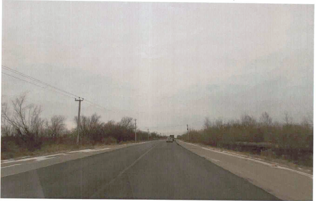
Фото № 14. Выполнение работ по восстановительному ремонту участков региональной сети автомобильных дорог, повреждённых при осуществлении перевозок грузов Концессионером (автодорога г. Хабаровск - с. Мичуринское – с. Федоровка – с. Смирновка - с. Галкино).
